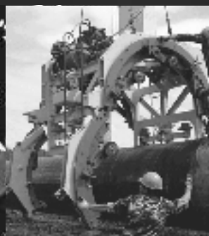
Изоляция и переизоляция труб
