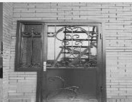
Производство и монтаж металлоконструкций
